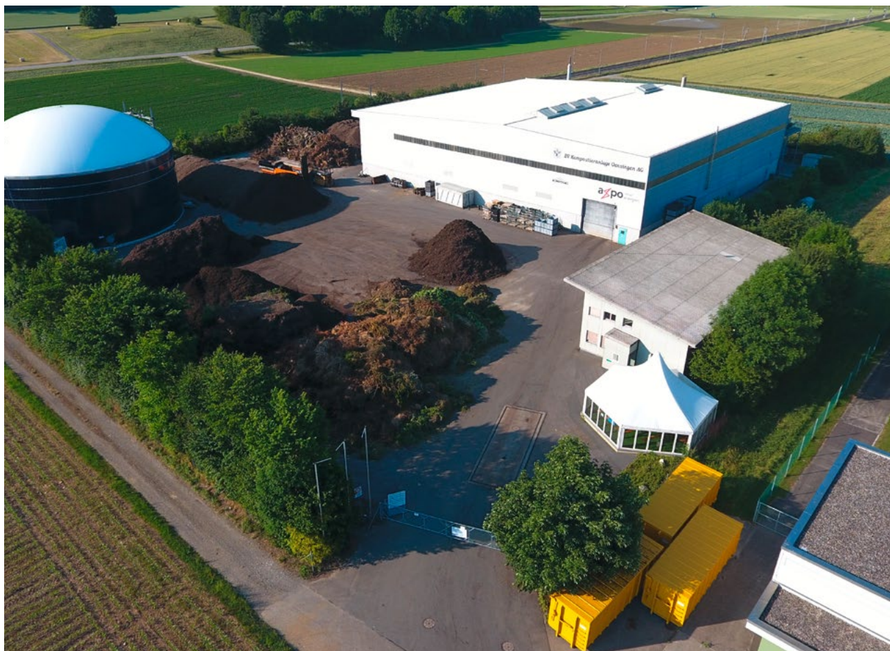
Ces dernières années, la production de biogaz a été multipliée par six.
