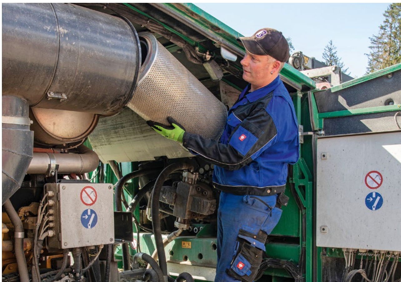
Lors des travaux d'entretien et de maintenance de la technique de traitement et de valorisation de déchets, la sécurité est un thème central
