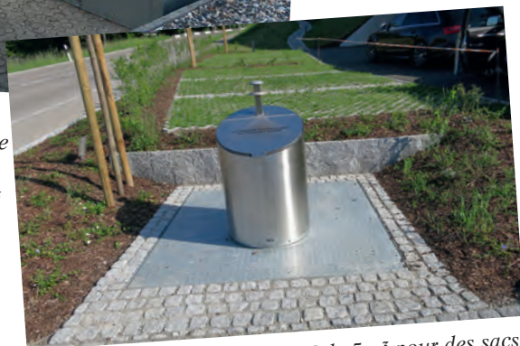
Container enterré du type GTU de 5m 3 pour des sacs de max. 110l avec une grande colonne de remplissage. Exécution KVA Thurgau.
